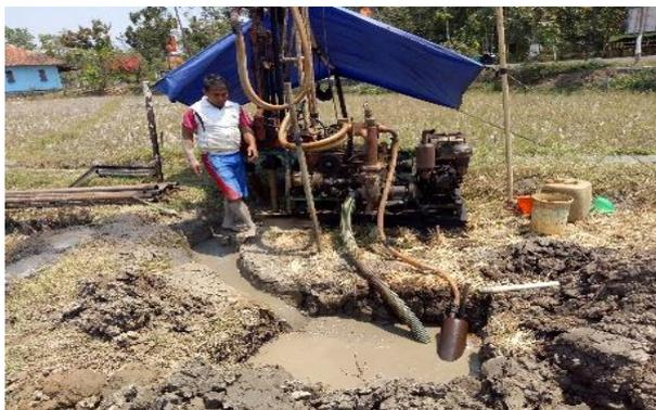
Gambar 1. Pembuatan Sumur Bor untuk Mengambil Air Tanah
